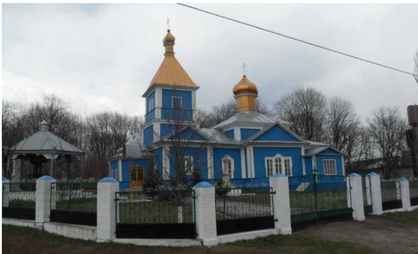
Fig. 24. Biserica „Acoperământul Maicii Domnului” din satul Malinovscje, raionul Râșcani
