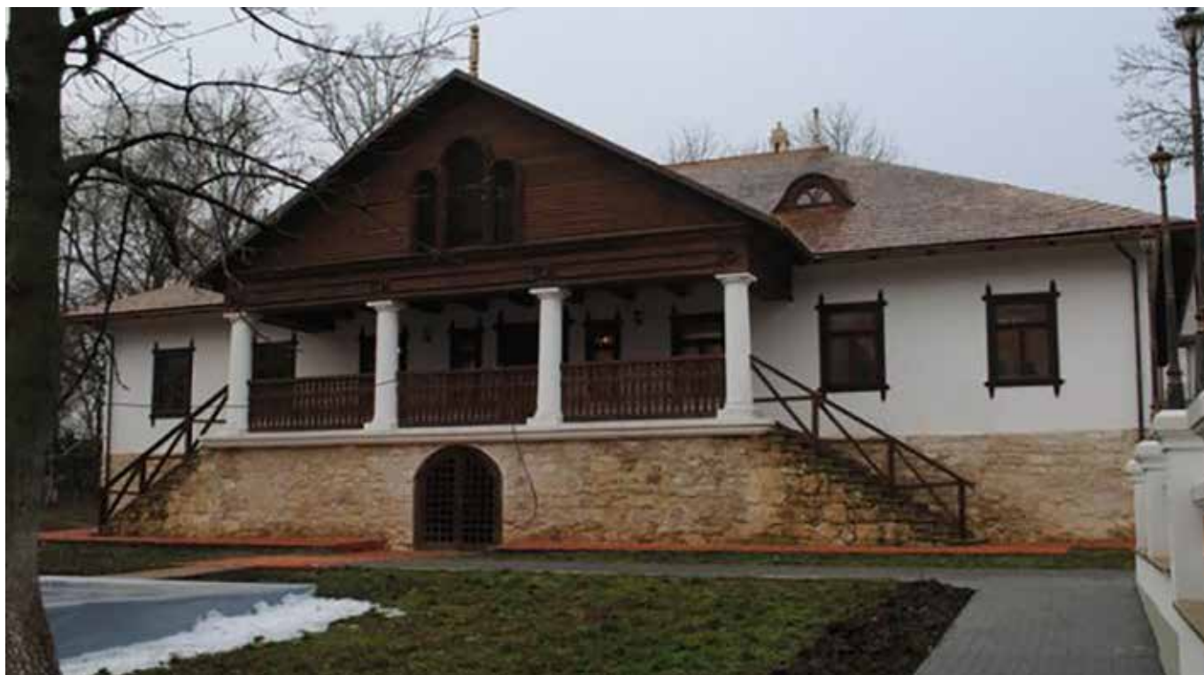
Fig. 6. Conacul lui Manuc-Bei din Hâncești. Vederea unei construcții auxiliare
