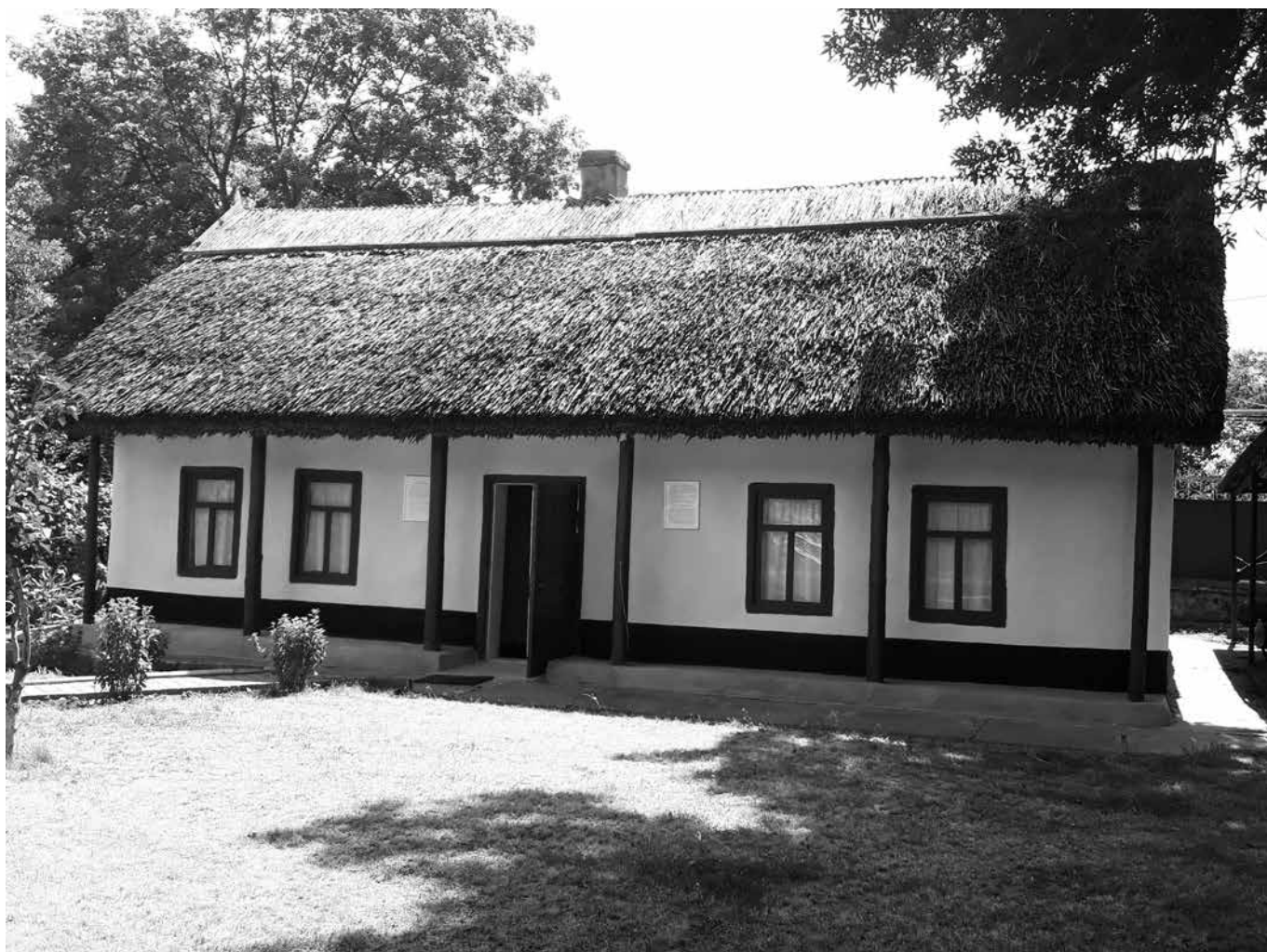
Fig. 6. Casă construită la sfârșitul sec. al XIX-lea. Orașul Cahul. Actualmente Muzeul de Etnografie din Cahul
