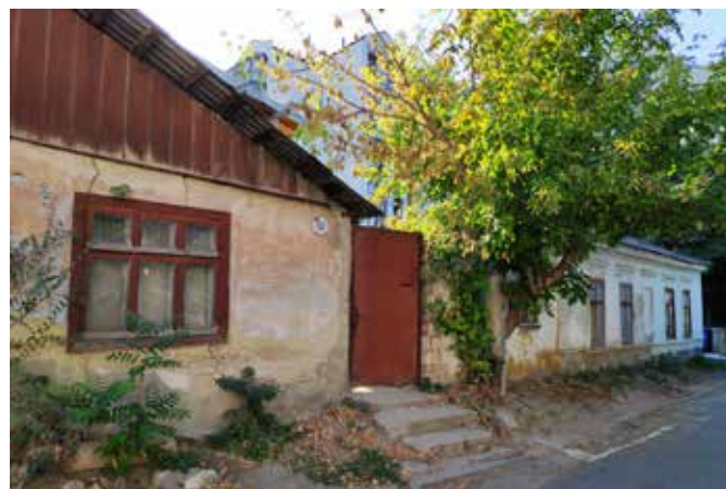
Fig. 3. Casa din Strada Romană, nr.13
