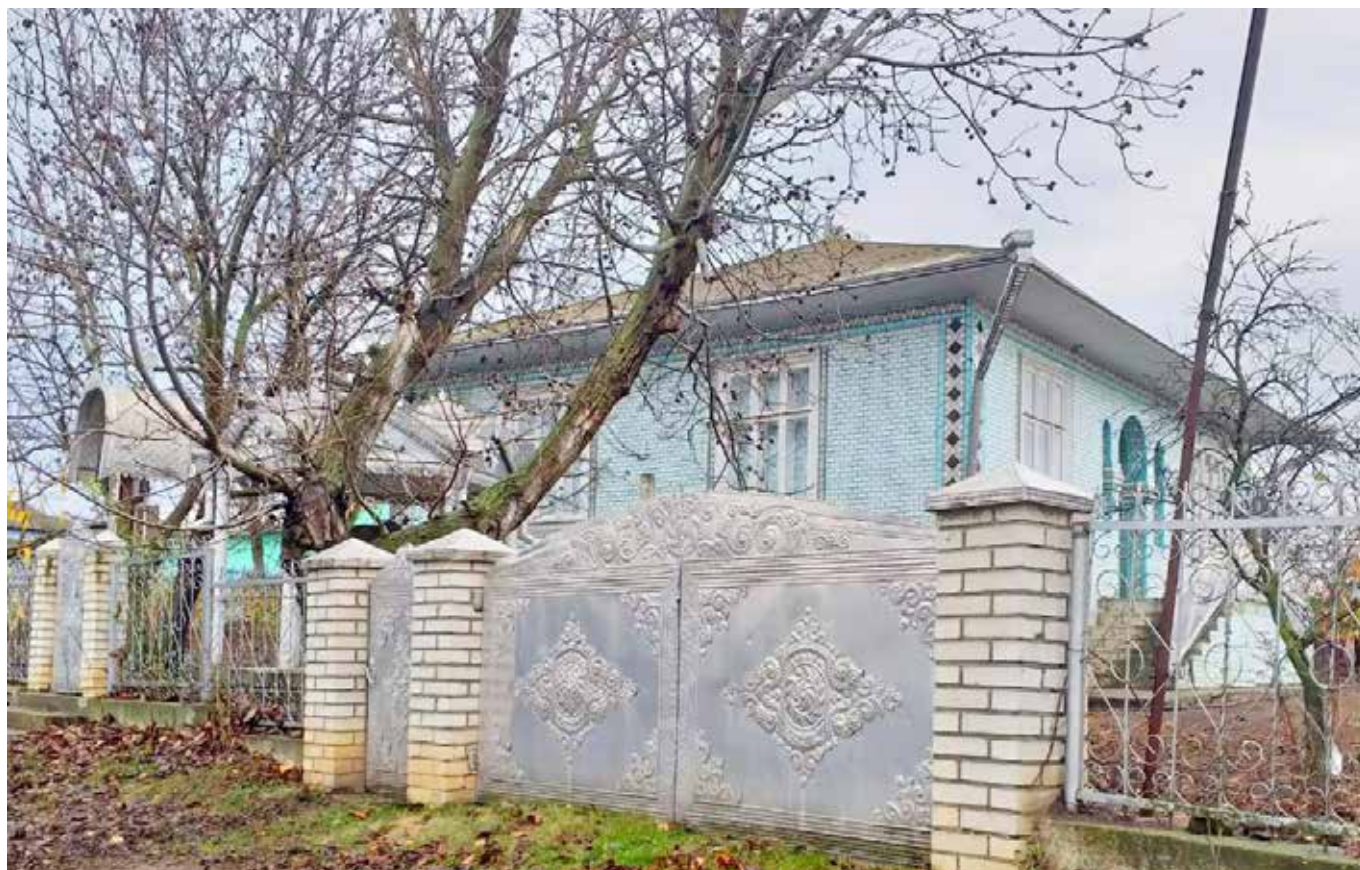
Fig.3. B. Gospodărie permanentă (modernizată) din satul Șuri, raionul Drochia
